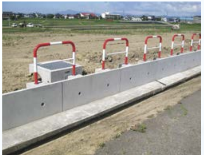
●温泉施設駐車場工事（妙高市）
