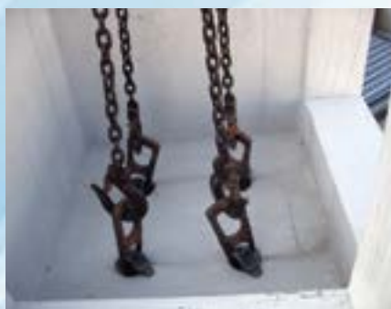
吊金具取付け
