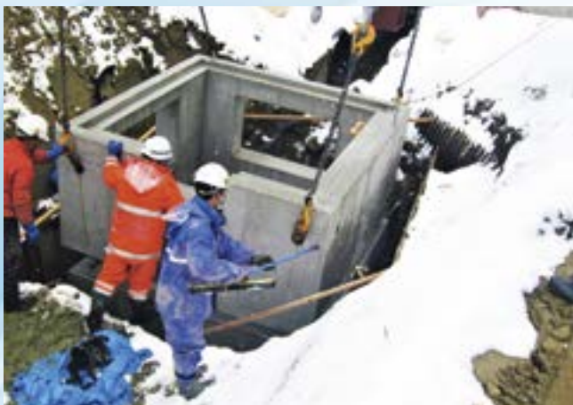
※可変型集水桝 2,000×2,000×2,500 (3分割) t=300 (施工例：上越市内) (写真左・2段目 写真右・3段目)
