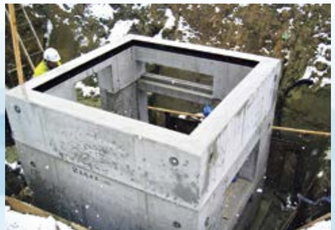
※可変型集水桝 2,000×2,000×2,500 (3分割) t=300 (施工例：上越市内) (写真左・2段目 写真右・3段目)
