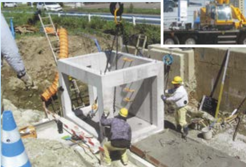
可変型集水桝据付
