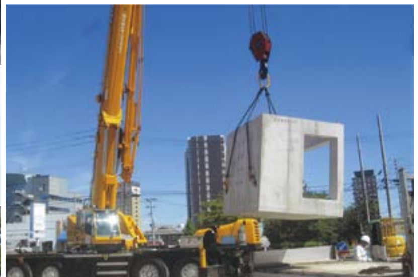
クレーン車による設置
